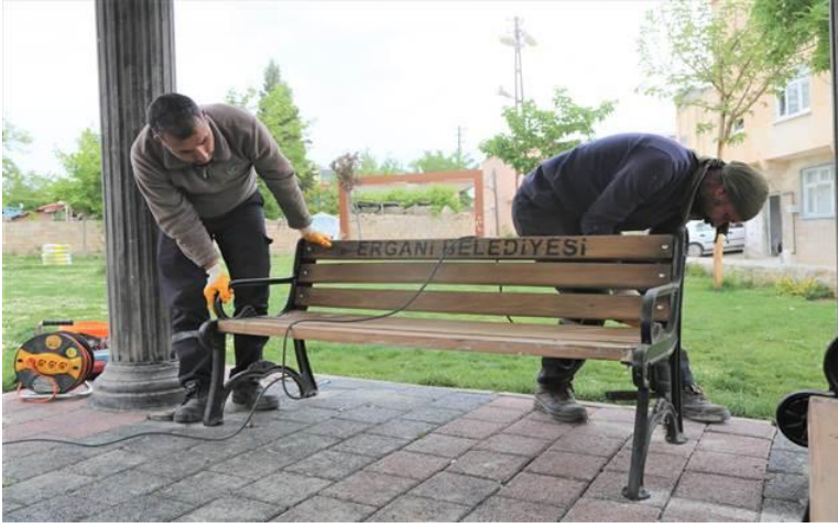
*Park alanlarında bakım onarım çalışması
