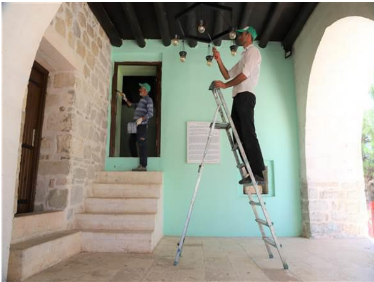
*Makam dağı türbesinin onarımı
