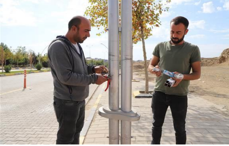
*Elektrik direklerinin onarım çalışması
