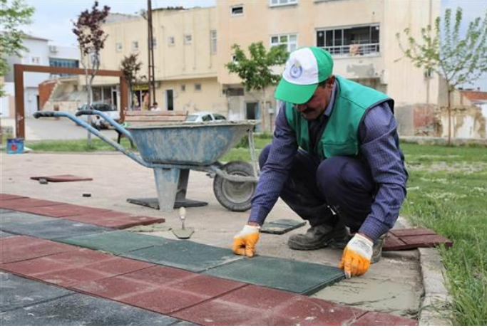
* Parklarda bakım onarım çalışması
