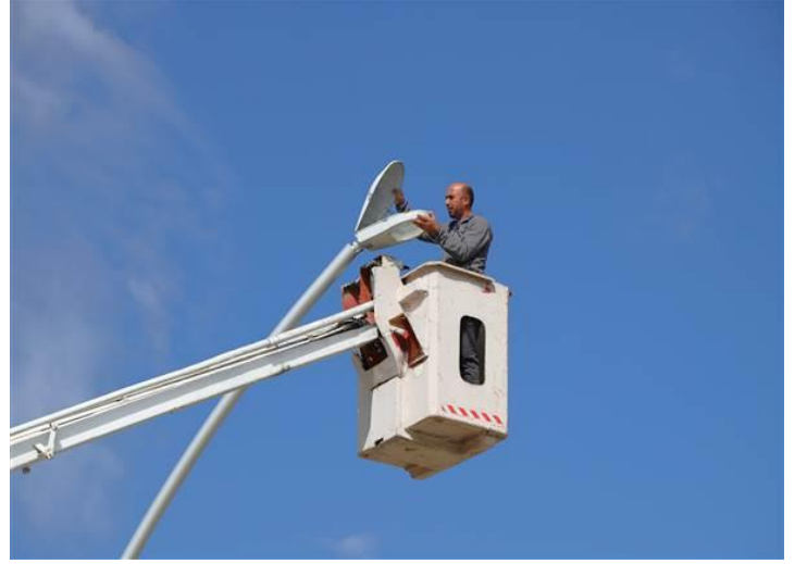
*Park alanlarının ışıklandırma sistemlerinin bakım işlemi
