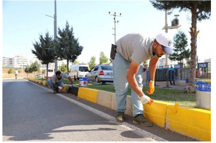
*Caddelerdeki bordür taşlarının boyanması
